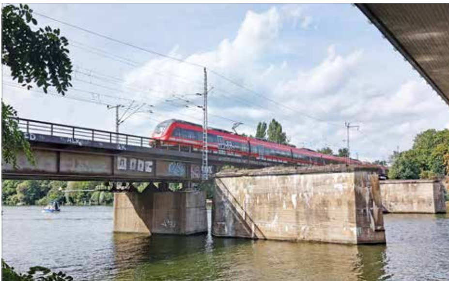
Neben der Spindlersfelder Brücke stehen noch die Stropfpieler der alten Spreebrücke von 1951. Hier ist ausreichend Platz für die zwei zusätzlichen Gleise der Nahverkehrstangente (NVT). Foto: Tom Gerlich
