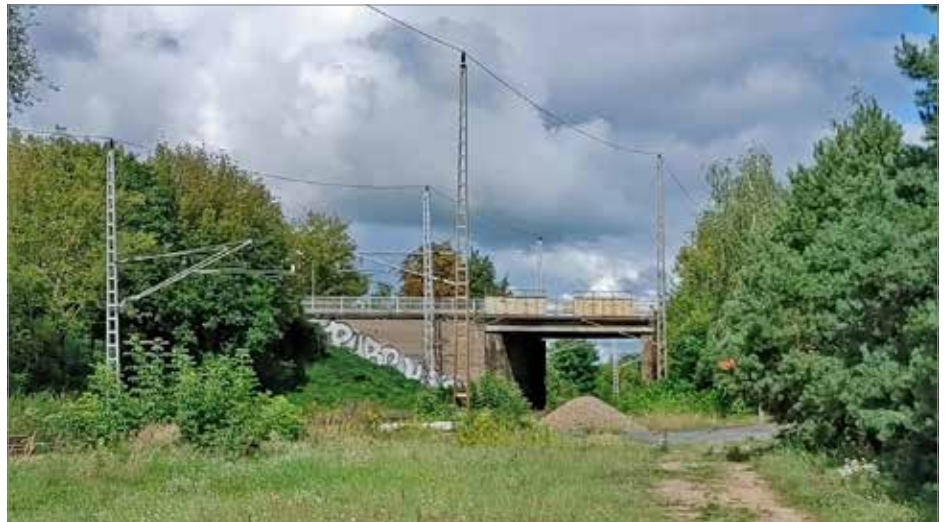
Bis zur Sellheimbrücke war die Verlängerung der S75 bereits im Bau. Nun steht der Neubau der Sellheimbrücke an. Hierbei müssen künftige Viergleisigkeit, Bahnsteig und Bushaltestelle auf der Brücke berücksichtigt werden! Foto: Christian Linow
