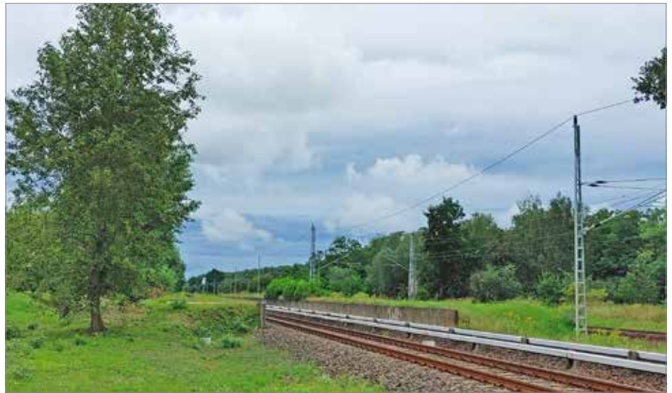
Vorleistung in Arkenberge für ein künftiges Wohngebiet an der S8. Während der Halt an der Bucher Straße weiter verfolgt wird, bleibt ein zur Schönerlinder Straße verschobener Halt nur optional. Foto: Christian Linow
