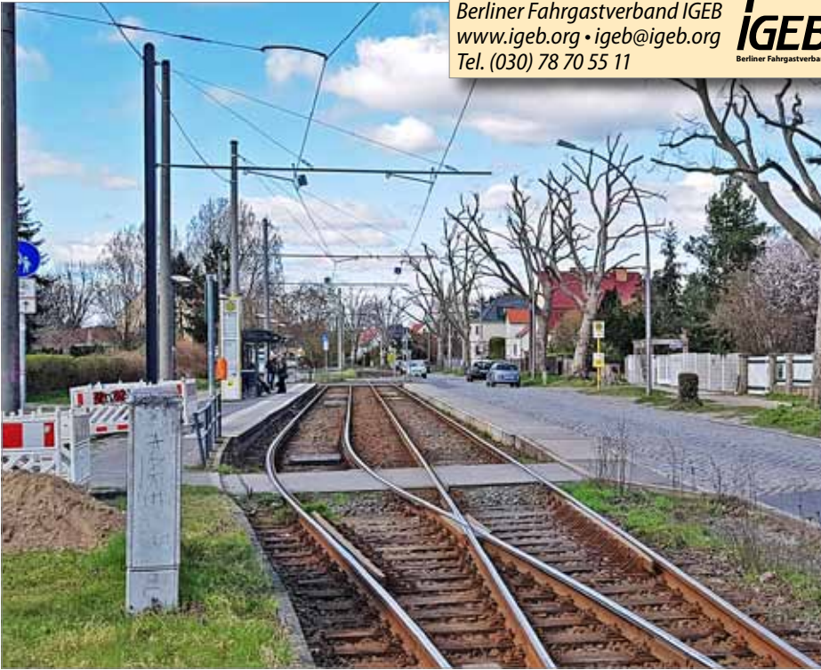
Am Wiesenwinkel liegen bereits zwei Gleise, die Haltestellen sind aber zu schmal, so dass das Haltestellenschild rechts von der Fahrbahn steht. Heute können hier noch Züge bei Betriebsstörungen enden. Künftig gibt es keine Weichen mehr.
