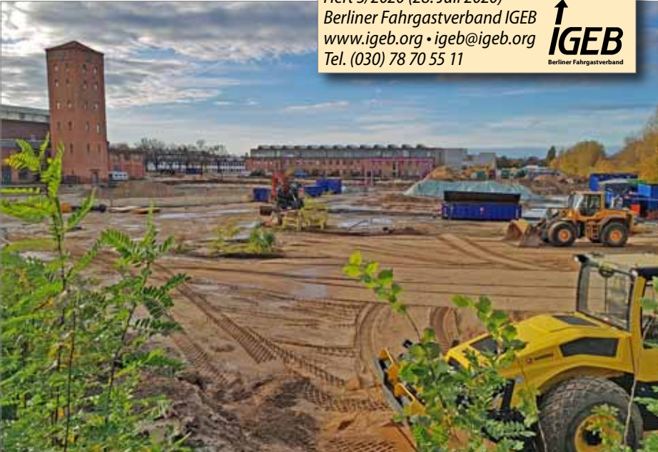
Auf der Insel Gartenfeld sind Arbeiten zur Baufeldfreimachung im Gange. Anstelle der Industrie- und Lagerhallen soll ein großes Wohngebiet entstehen, das mit längeren Fußwegen an den historischen Bahnhof Gartenfeld angebunden ist. Eine Straßenbahn soll das neue Wohngebiet hineinfahren. Foto: Florian Müller
