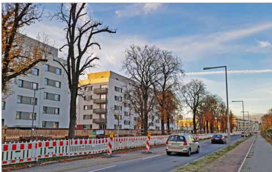
An der Daumstraße in Haselhorst wachsen die Wohnhäuser in die Höhe. Auch in der Nachbarschaft wird an beiden Ufern der Havel („Wasserstadt Oberhavel“) der Wohnungsbau vorangetrieben. Eine Verkehrserschließung besteht bisher nur durch (überlastete) Busse – und das eigene Auto. Die Straßenbahn zum S-Bahnhof Gartenfeld würde die Situation deutlich verbessern. Deshalb muss umgehend mit den Planungen begonnen werden. Foto: Florian Müller
