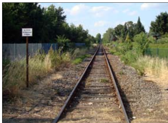
Gleis der hvle in der Nähe des Kiesteichs. Hier könnte ein zweigleisiger Abschnitt bis zum S-Bahnhof Falkenseer Chaussee entstehen.
