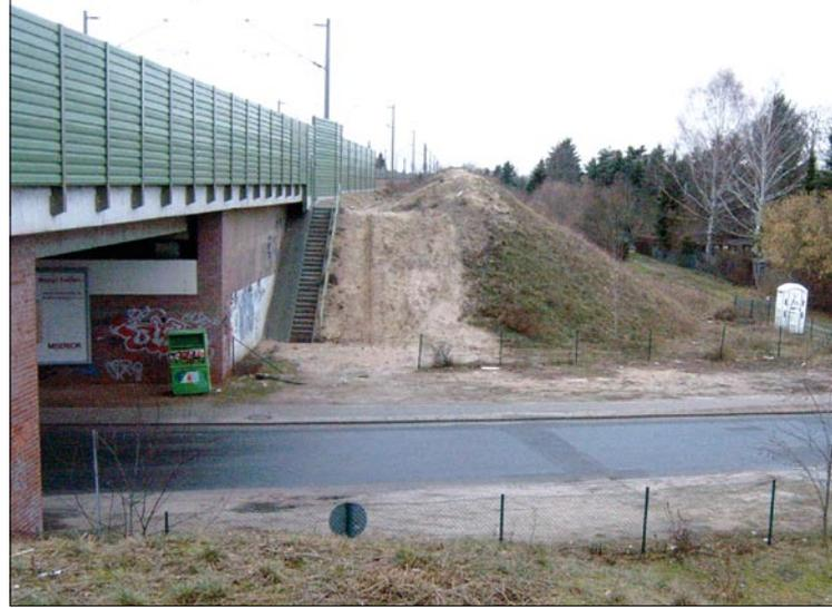
*Spandau, Hackbuschstraße. Der Bahndamm für die Verbreiterung um ein oder zwei weitere Gleise ist bereits größtenteils fertig. Die Brückenbauwerke können einfach ergänzt werden.*
